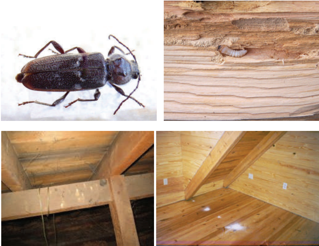
Сл. 26. Hylotrupes bajulus L. – имаго, ларва и оштетувања на кровна конструкција
